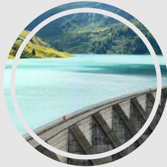
Válvulas y Bombas
